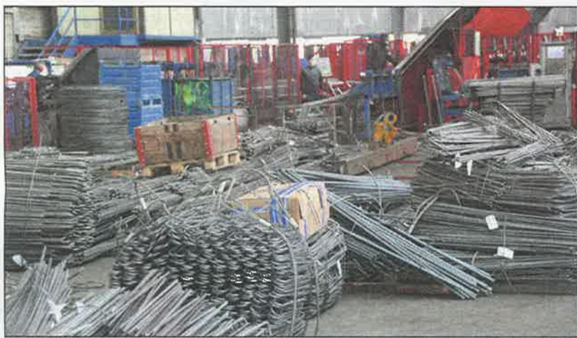
Le site façonne des aciers d'armature.
